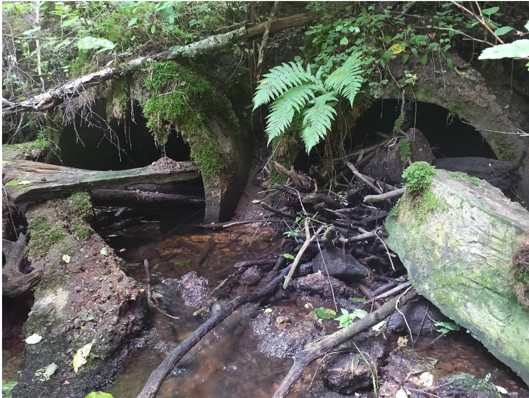
Joonis 6. Paisu binokkeltruup, mis avaneb Võsu jõkke.
