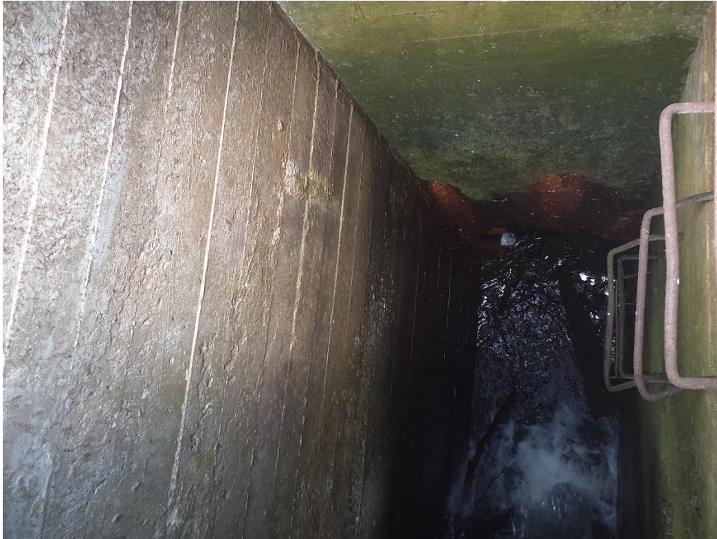
Joonis 3. Ojaäärse I paisu betoonist kaev.
